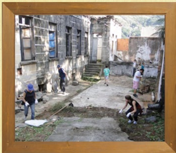
TRABALHO DE LIMPEZA E RESTAURAÇÃO DA NOVA SEDE DA BEIT TEFILAH RECHOVOT
