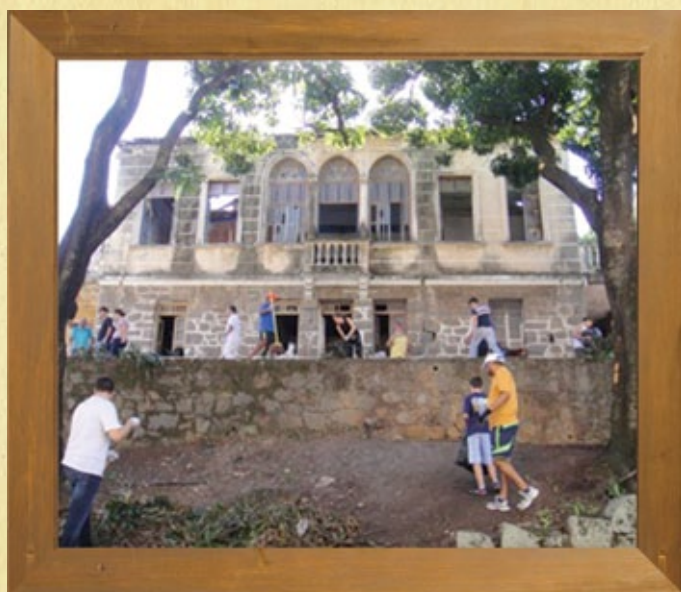
TRABALHO DE RESTAURAÇÃO DA NOVA SEDE DA BEIT TEFILAH RECHOVOT
